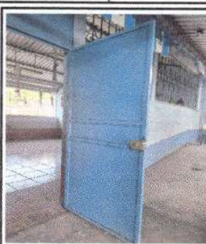
Foto 2: MÓDULO 2 AULAS PUERTAS DE METAL: Mantenimiento a estructura (lijado, cambio de tubo, cepillado, sujeciones, aplicación de pintura); Sustitución de chapa
