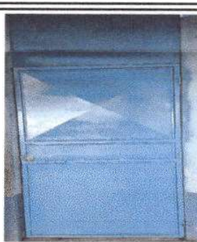
Foto 2: MÓDULO 2 AULAS PUERTAS DE METAL: Mantenimiento a estructura (lijado, cambio de tubo, cepillado, sujeciones, aplicación de pintura); Sustitución de chapa
