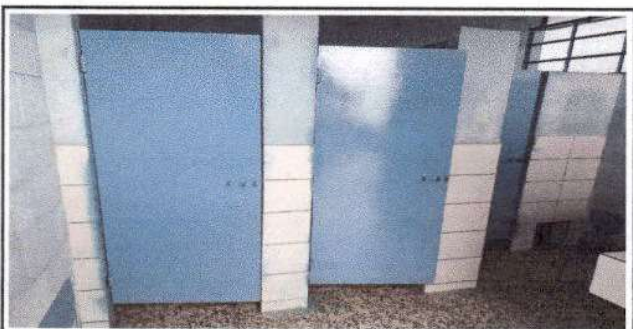
Foto 5: MÓDULO 3 SERVICIOS SANITARIOS: PUERTAS DE METAL: Mantenimiento a estructura (lijado, cepillado y aplicación de pintura);
