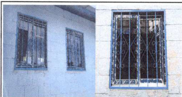
Foto 3: MÓDULO 2 AULAS VENTANAS: Sustitución de estructura de soporte de metal de ventana (balcones); Sustitución de ventanas de madera por PVC
